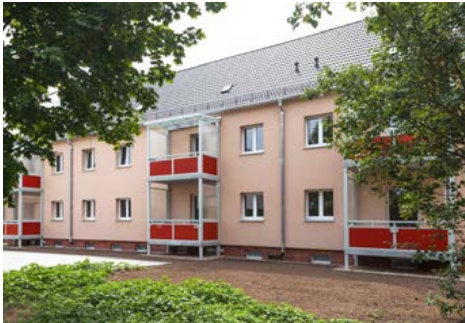
Komplexe Modernisierung in der Goyatzer Straße 4-5
