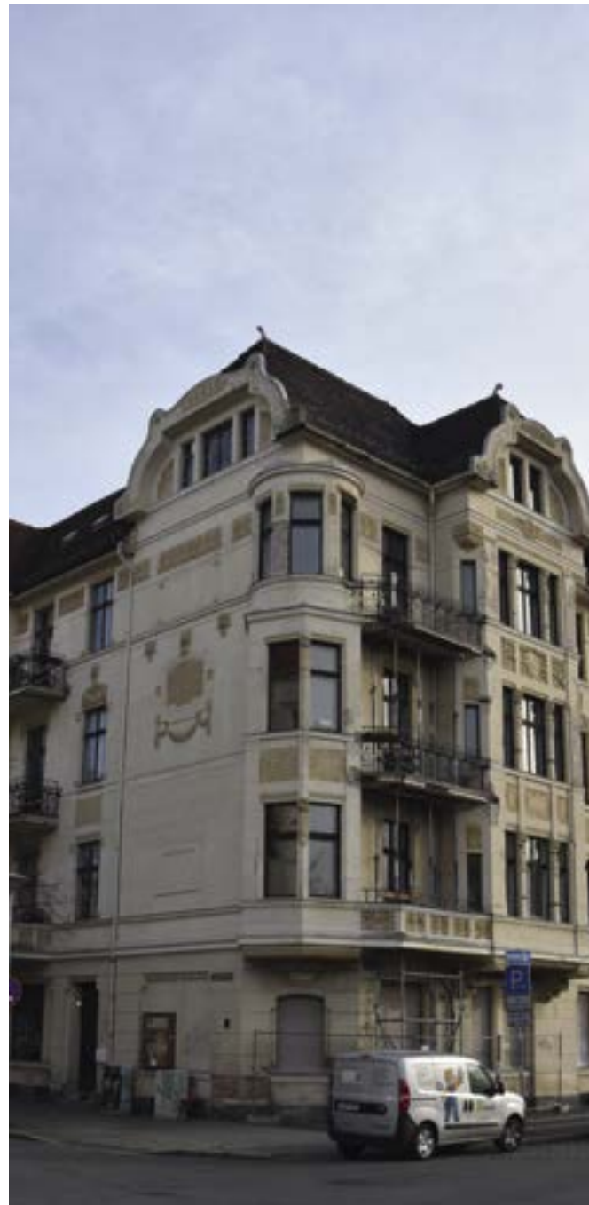
Komplexinstandsetzung der August-Bebel-Straße 11
