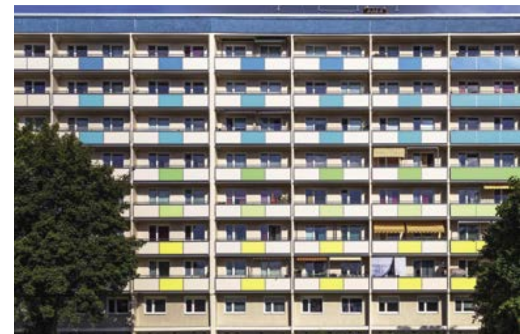
Farblich neu gestaltete Fassade und Balkone in der Hans-Beimler-Straße 1 - 1 a.
