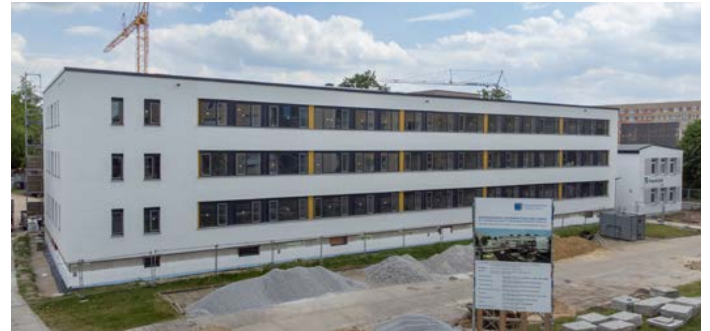
Bürohaus am Campus
