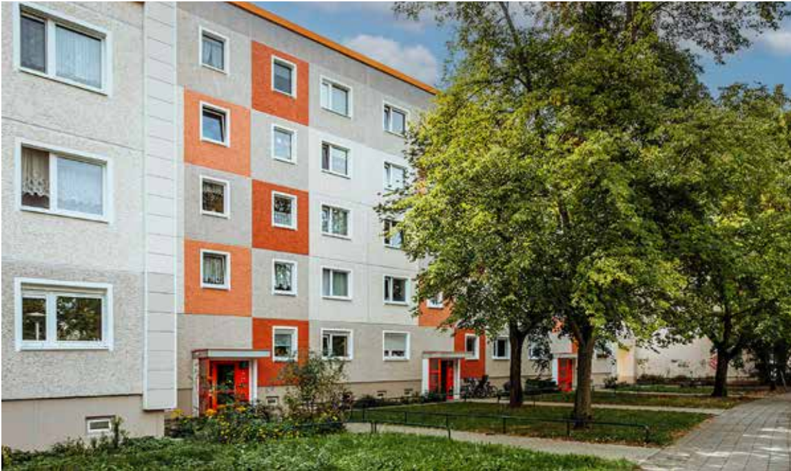
Fassaden- und Balkon-Instandsetzung, Erfurter Straße 14-21
