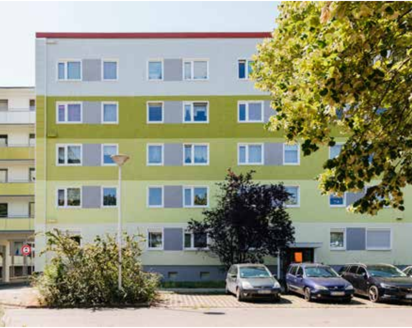
Fassadeninstandsetzung und Anbau neuer Balkone in der Geraer Straße 1 - 7.
