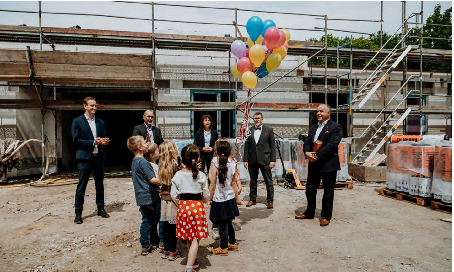
Grundsteinlegung Kita-Neubau Rostocker Straße 3
