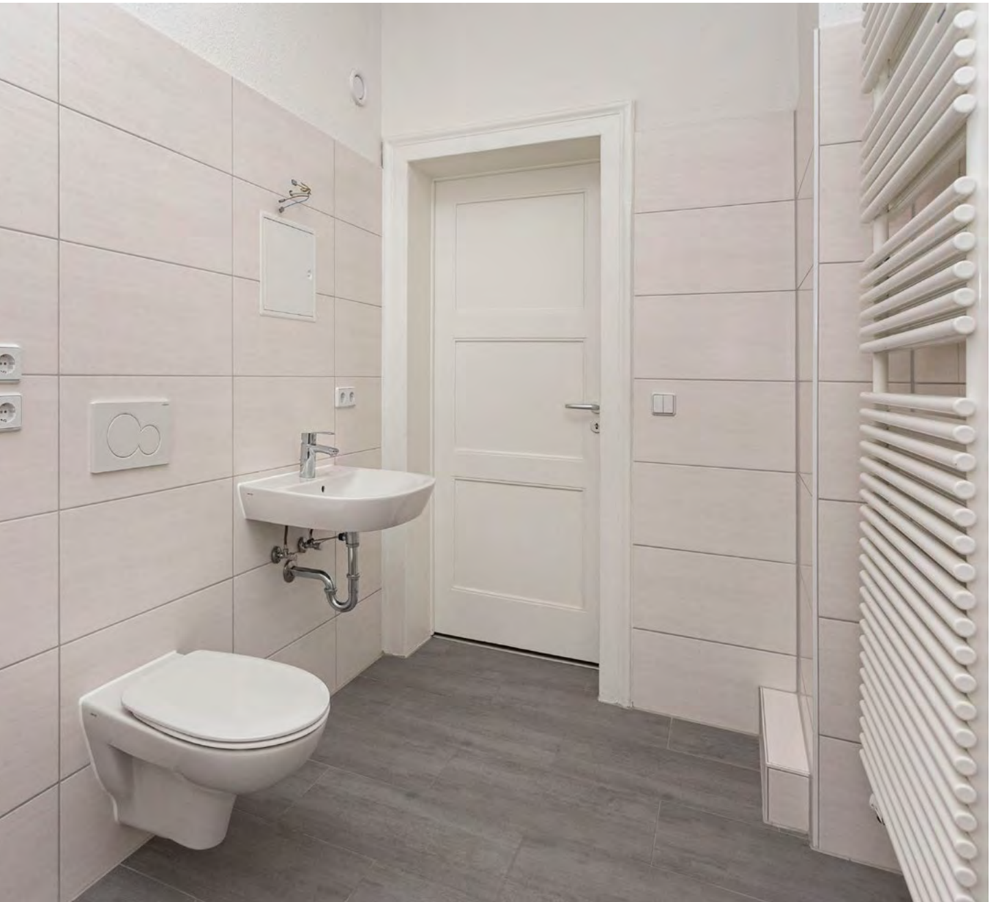
Komplexinstand- setzung von 2- und 3-Raum-Wohnungen, Räschener Straße 28
