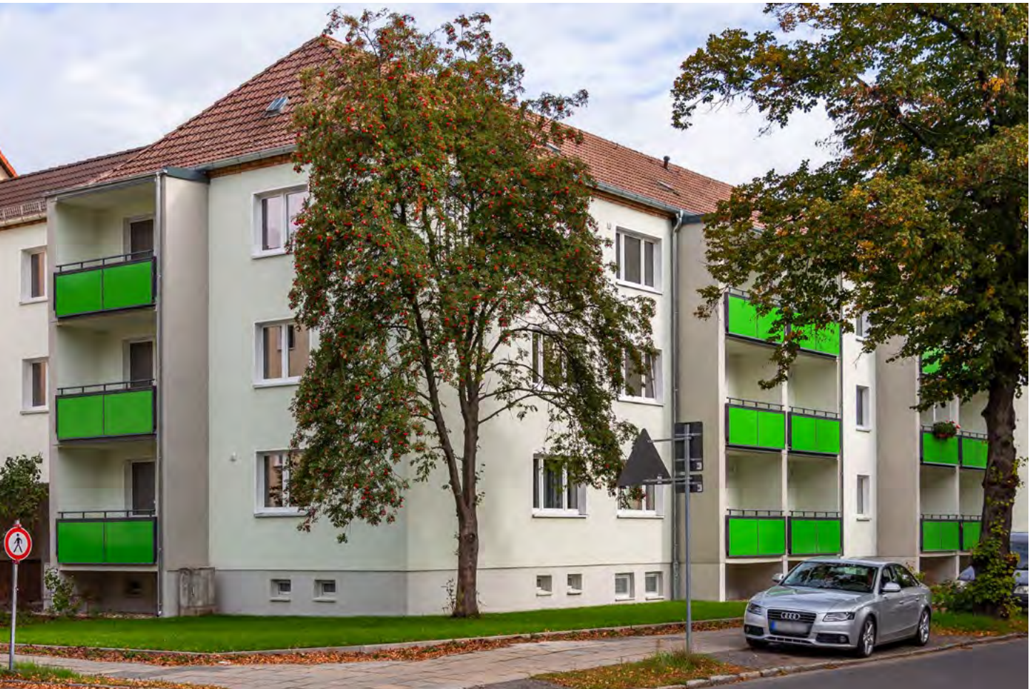
Komplexinstandsetzung Leipziger Straße 41
