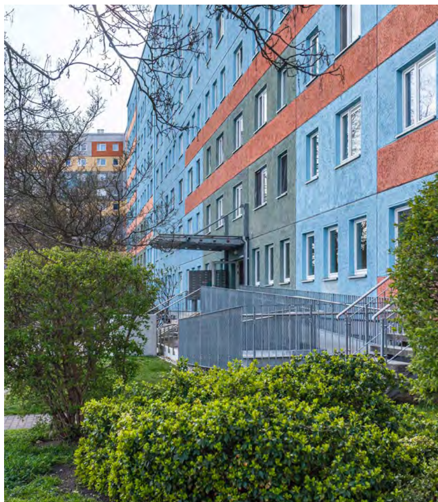
Rampenanbau in der Berthold-Brecht-Straße 5
