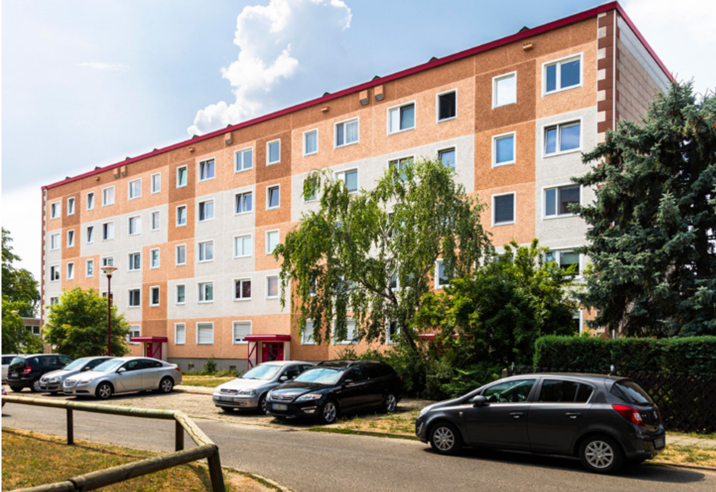
Balkon- und Fassaden- instandsetzung Saarstraße 6–9
