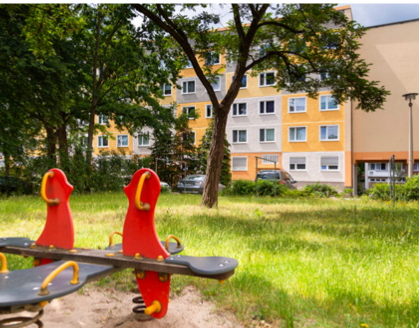
Balkon- und Fassaden- instandsetzung Hainstraße 24–28
