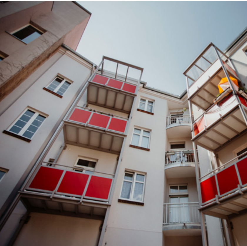
Anbau neuer Balkone Karlstraße 94/ Deffkestraße 6a
